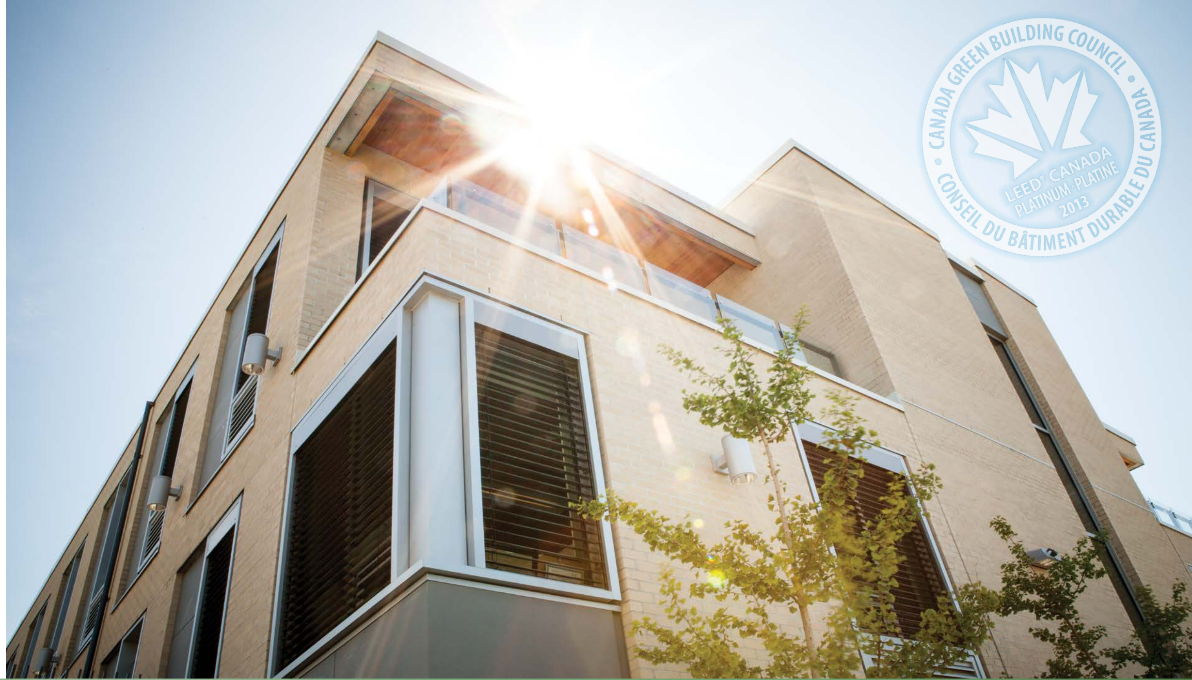
Edificio con certificación LEED Platinum de la sede de Reliable Controls
